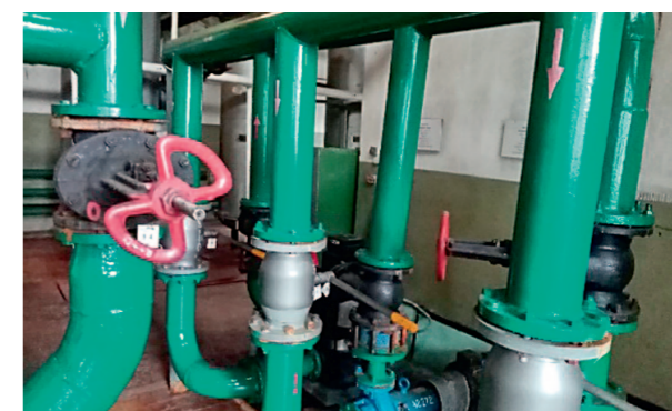
Рис. 6. Состояние поверхности после 2 лет эксплуатации
