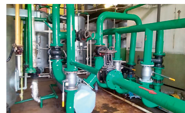
Рис. 5. Состояние поверхности после 1 года эксплуатации
